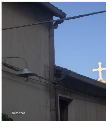
Particolare grondaia lato Ovest
