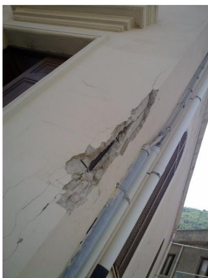
Particolare angolo prospetto principale
