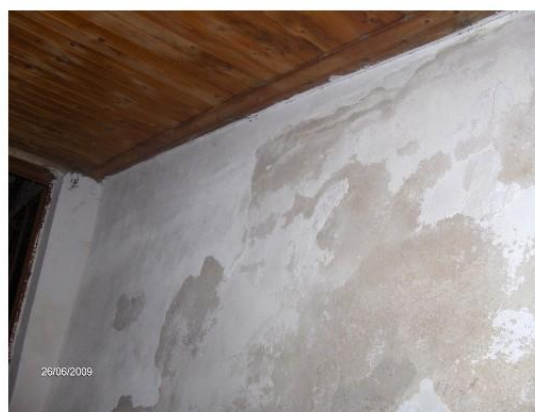
Particolare locali annessi alla sagrestia
