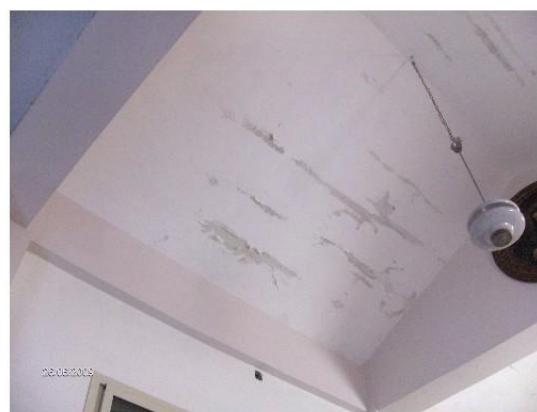
Interno chiesa: particolare del soffitto
