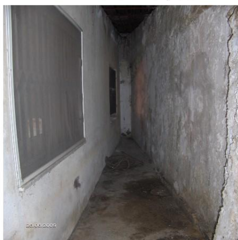
Particolare locali annessi alla sagrestia
