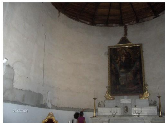
Interno chiesa - Abside
