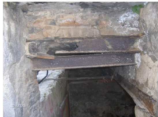
Particolare travi solaio sottopassaggio piazzetta
