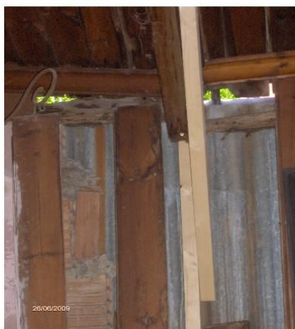
Particolare parete interna lato Est
