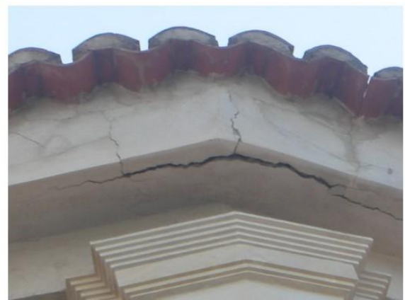
Particolare cornice prospetto principale
