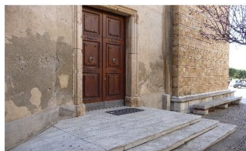
Particolare prospetto lato Est
